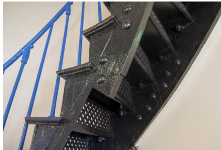
De wenteltrap en tussenvloeren van de Vuurtoren zijn gemaakt in 1864. Vakwerk uit geklonken staal dat de sfeer van de industriële revolutie ademt. © Vuurtoren Texel
